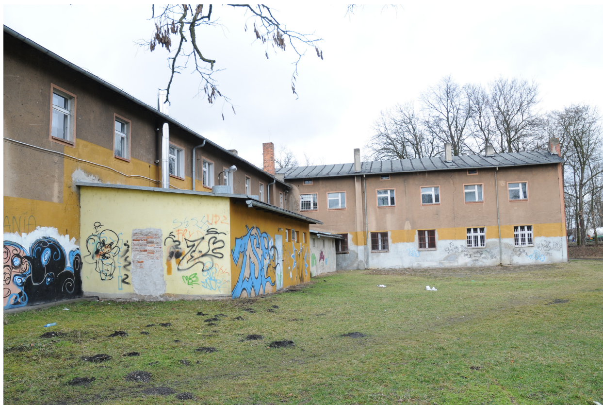
Fot.6 Budynek dydakt. A – elewacja południowa. Budynek dydakt. B – elewacja wschodnia.
