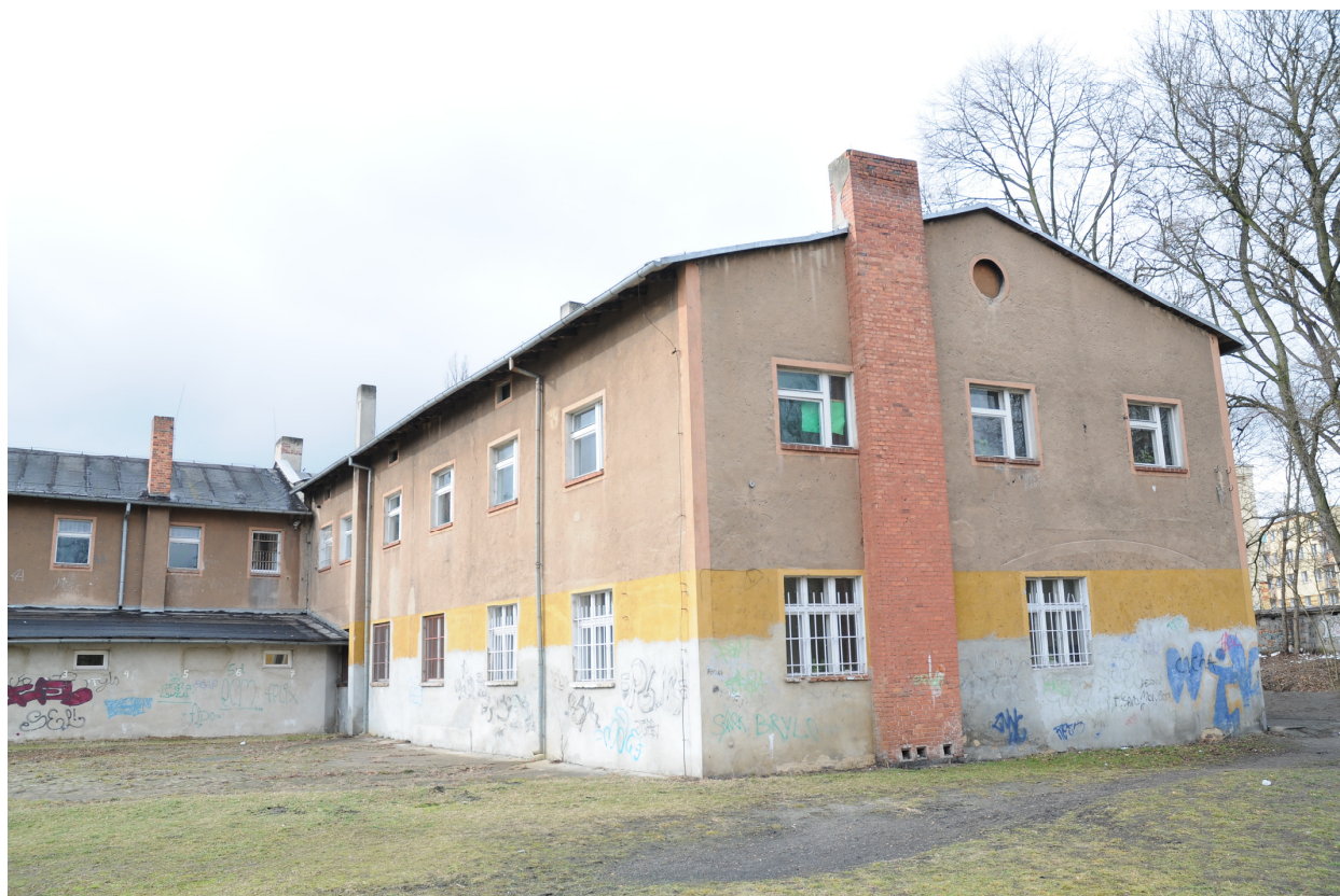
Fot.5 Budynek dydaktyczny A – elewacja południowa i wschodnia.
