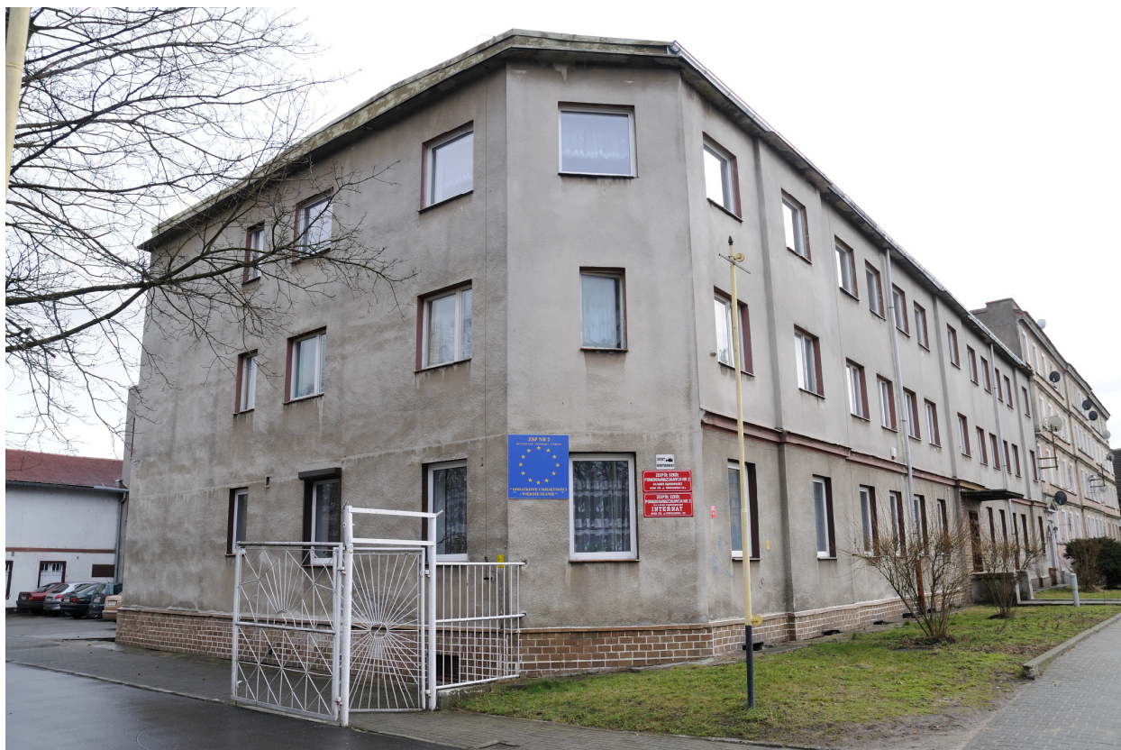
Fot.1 Internat – elewacja północna i zachodnia.
