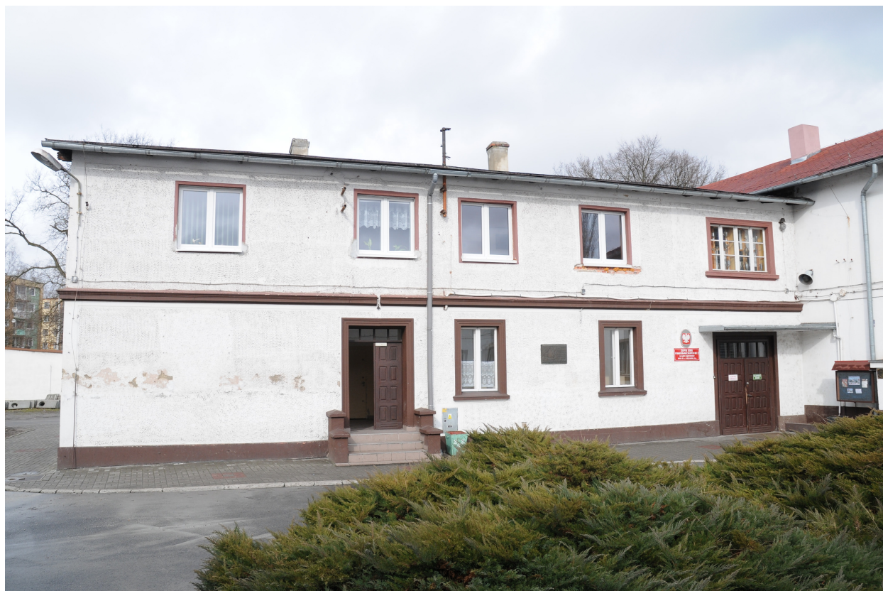
Fot.3 Budynek biurowy – elewacja południowa.
