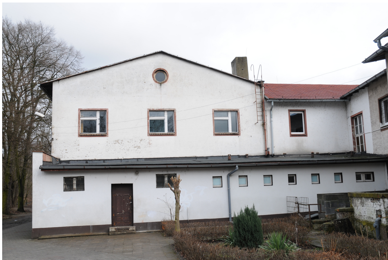
Fot.4 Budynek dydaktyczny A – elewacja zachodnia.
