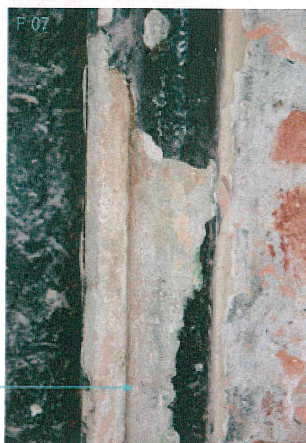
P 02 Plansza przedstawia stan zachowania XIX - wiecznego portalu. Fotografia F 04 ukazuje, odwrócić obiektu wraz z pierwotnymi elementami mocowania stolarki drzwiowej. F 05, zbliżenie wtórnych nawarstwień i ich zniszczenia na skutek działania wilgoci. Wtórne, powłokowe płaskie wymalowania nietrwałe. F 07, widoczne samoistne odspojenia ukazujące pierwotną powierzchnię portalu wraz z wcześniejszymi przemalowaniami. Stan zachowania obiektu i charakter zniszczeń wskazuje wodę, jako główną przyczynę uszkodzeń.
